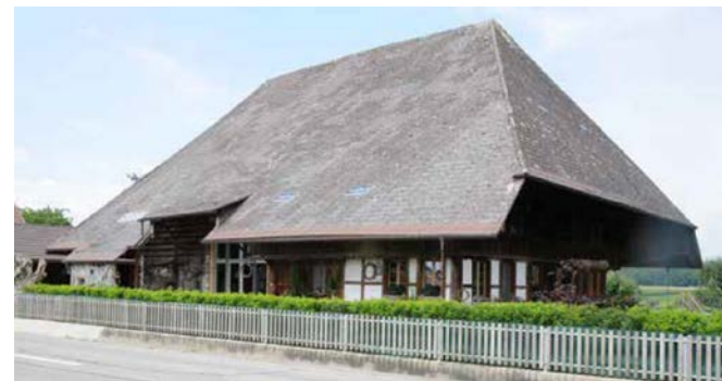
Gutes Beispiel: Umnutzung Bauernhaus, Belichtung 1. Geschoss mit geringer Tiefe von der Giebelseite (Zauggenried)
