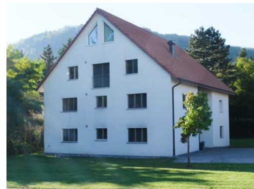
Gutes Beispiel: Neubau in einer Kernzone unter Berücksichtigung der typischen baulichen Strukturen (Geschosshöhe, Dachform (insb. Dachneigung) (St. Pantaleon)
