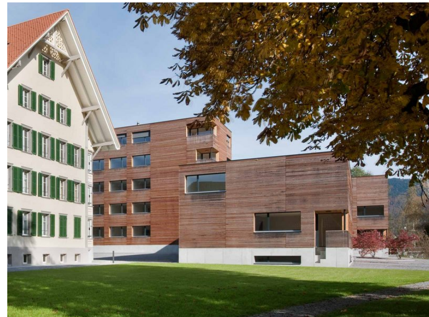
Gutes Beispiel: Transformation alte Mühle in Wohnen mit Erhalt des Müllererhauses (links) und Neubauten (rechts) (Herbligen)
